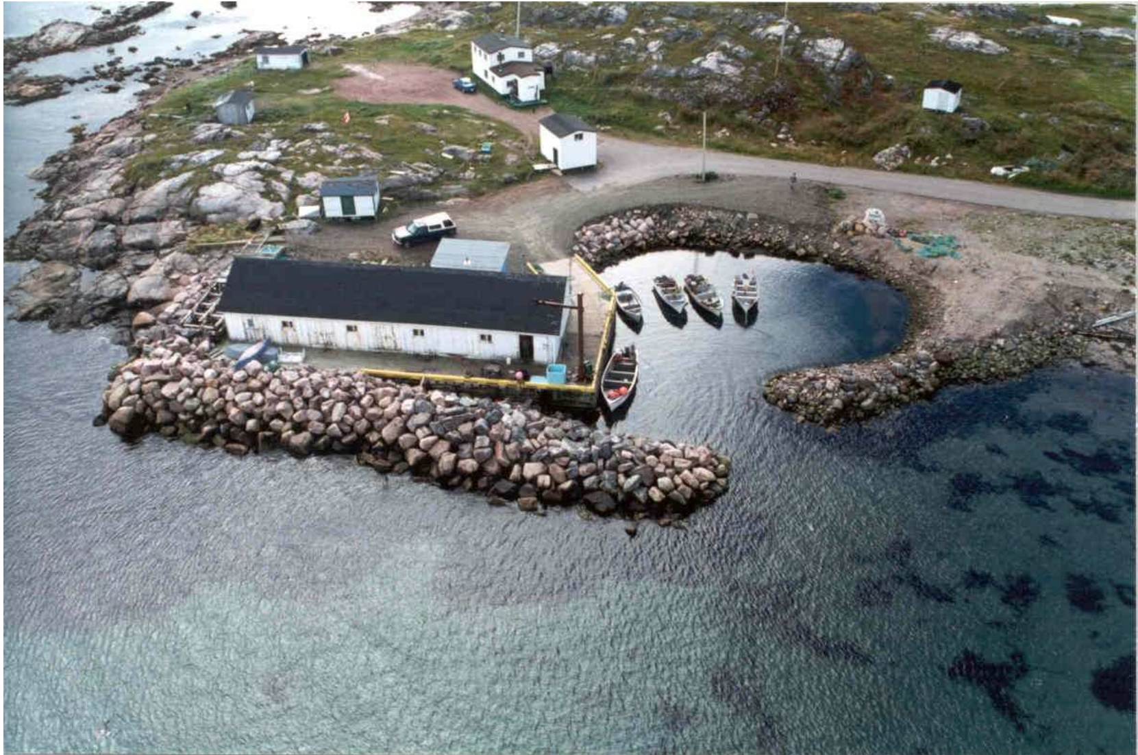
Photographie du site : vue aérienne du site de dragage de Capstan Island.
