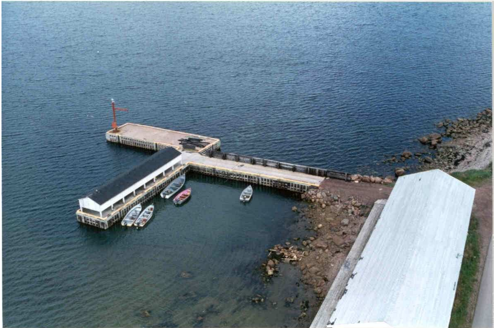
Photographie du site : vue aérienne du site de dragage de Pinware.
