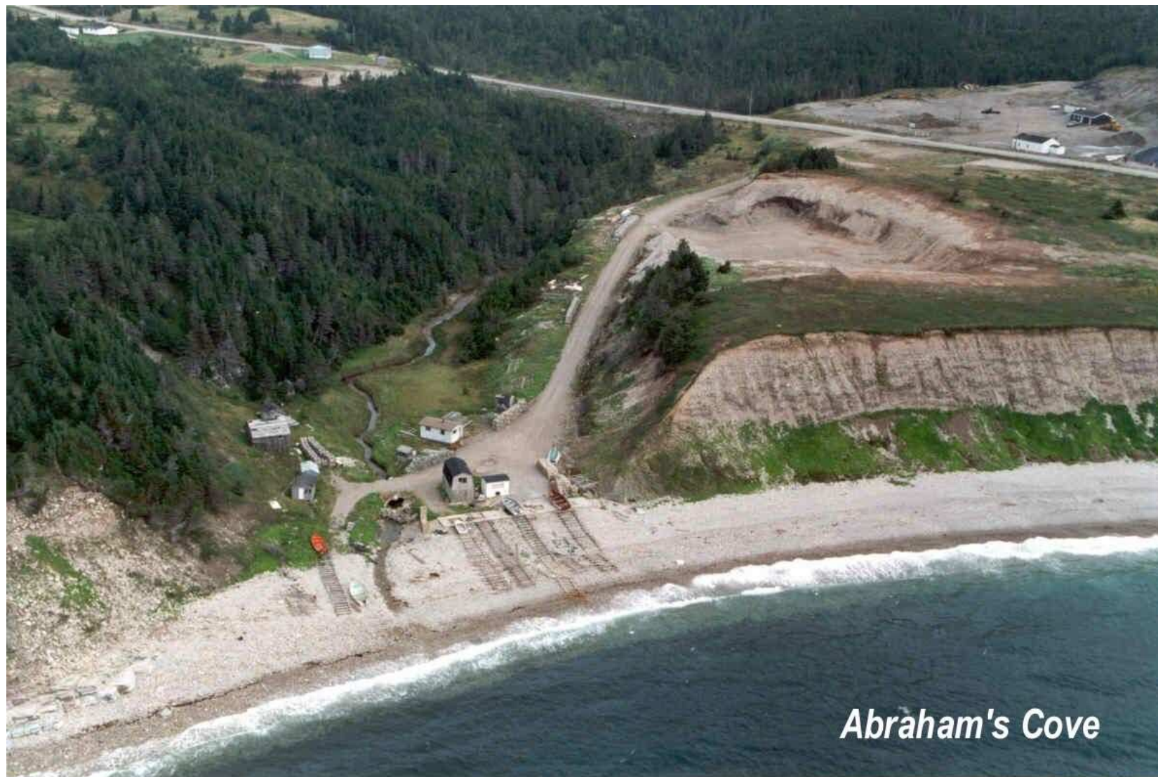
Photographie du site : vue aérienne du site de nivellement de la plage d'Abraham's Cove (voir rampes d'accès à l'eau).
