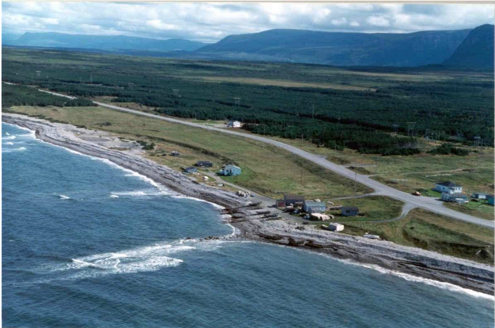
Photographie du site : vue aérienne du site de dragage de Sally's Cove.
