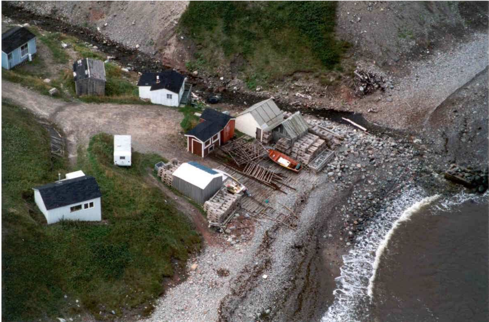
Photographie du site : vue aérienne du site de nivellement de la plage d'Heatherton.
