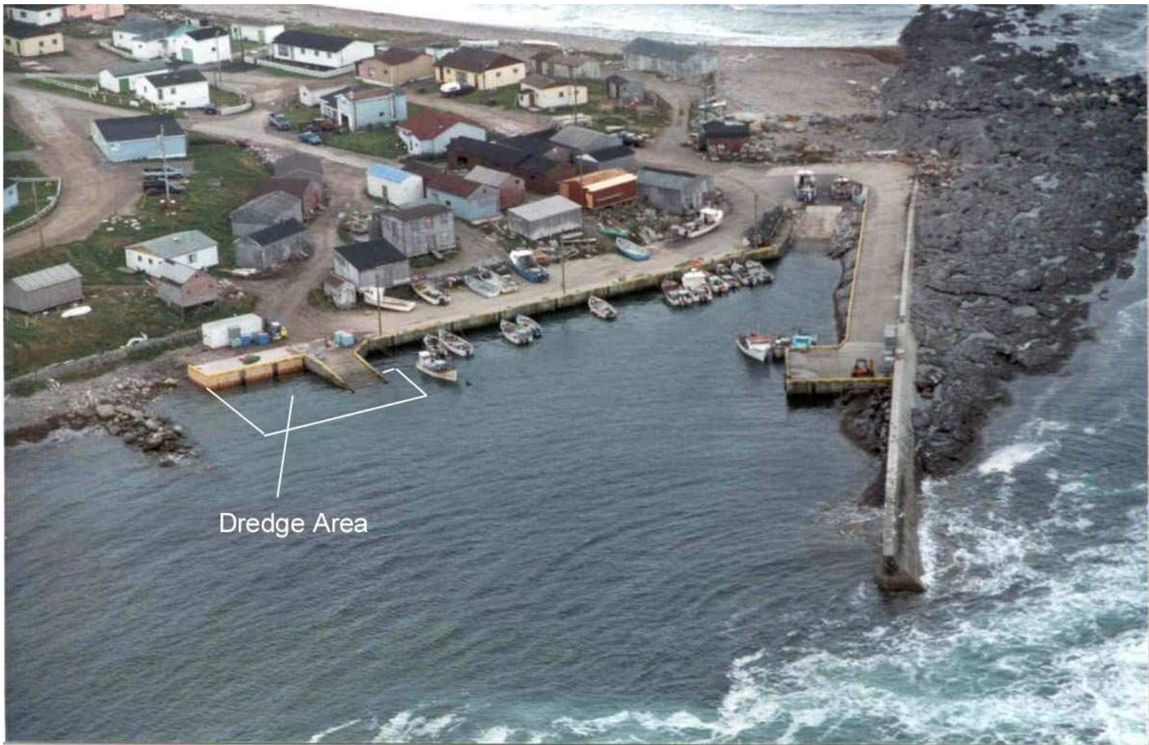
Photographie du site : vue aérienne du site de dragage de Daniel's Harbour.
