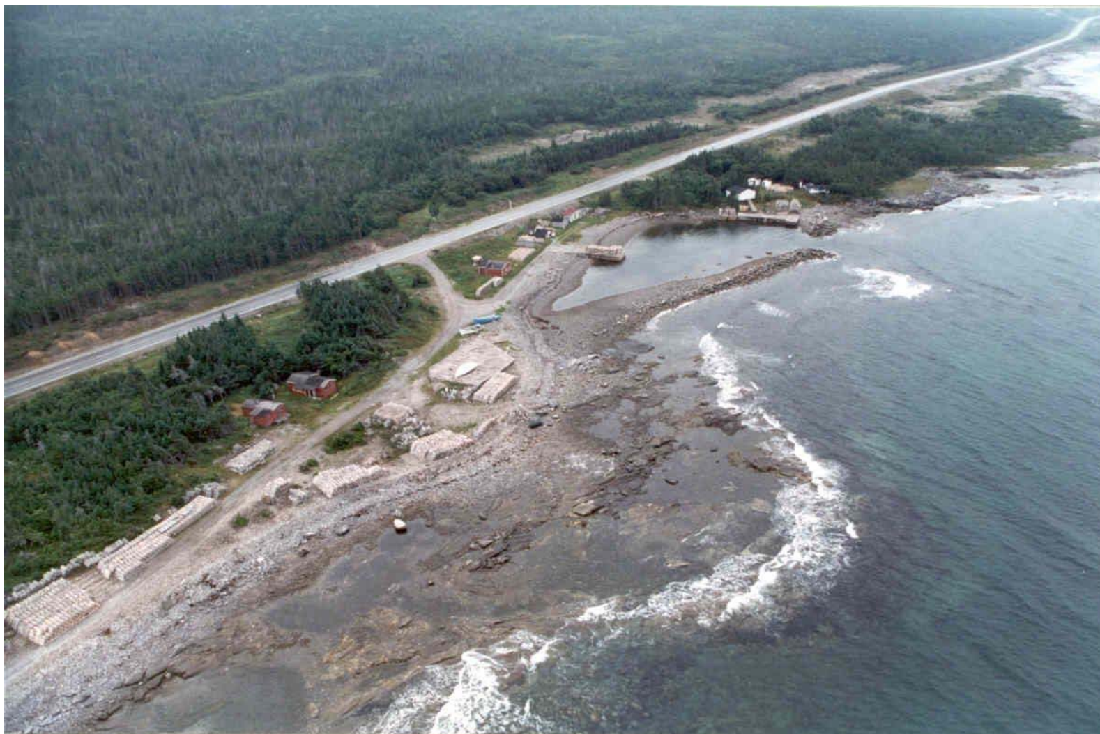
Photographie du site : vue aérienne du site de dragage de Josephine's Cove.
