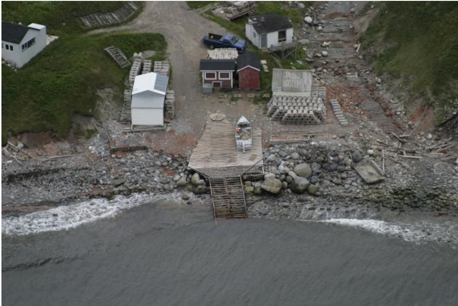
Photographie du site : vue aérienne du site de nivellement de la plage de Seal Cove.
