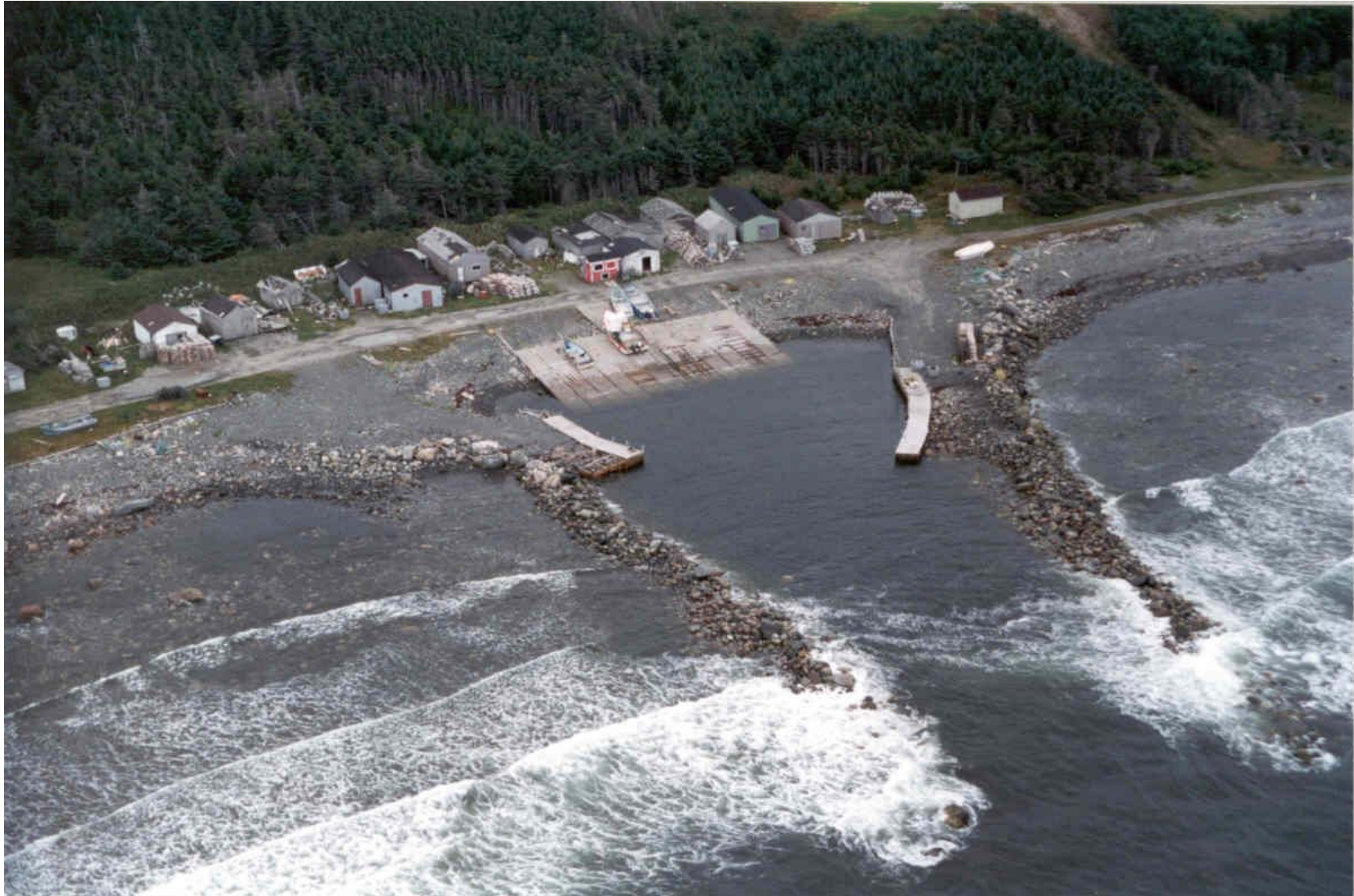
Photographie du site : vue aérienne du site de dragage de Three Mile Rock.
