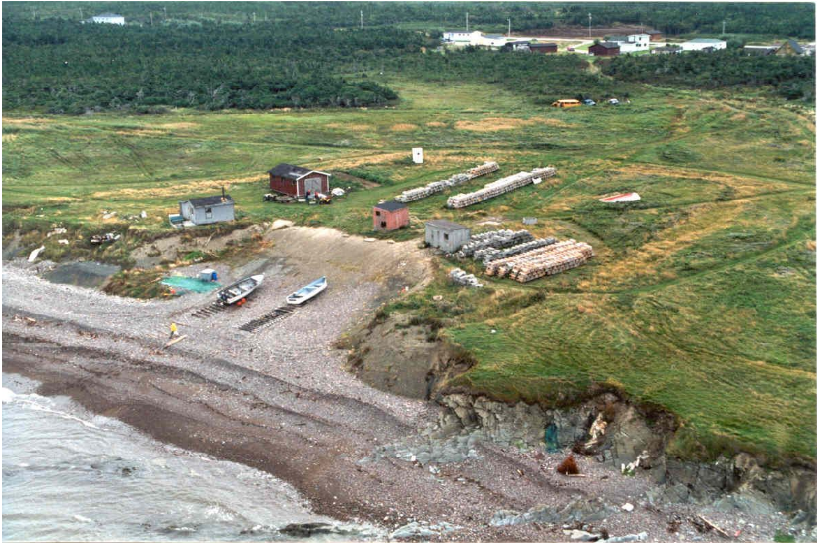
Photographie du site : vue aérienne de la plage de Mainland – du site de nivellement de la plage de Benoit’s Landing.
