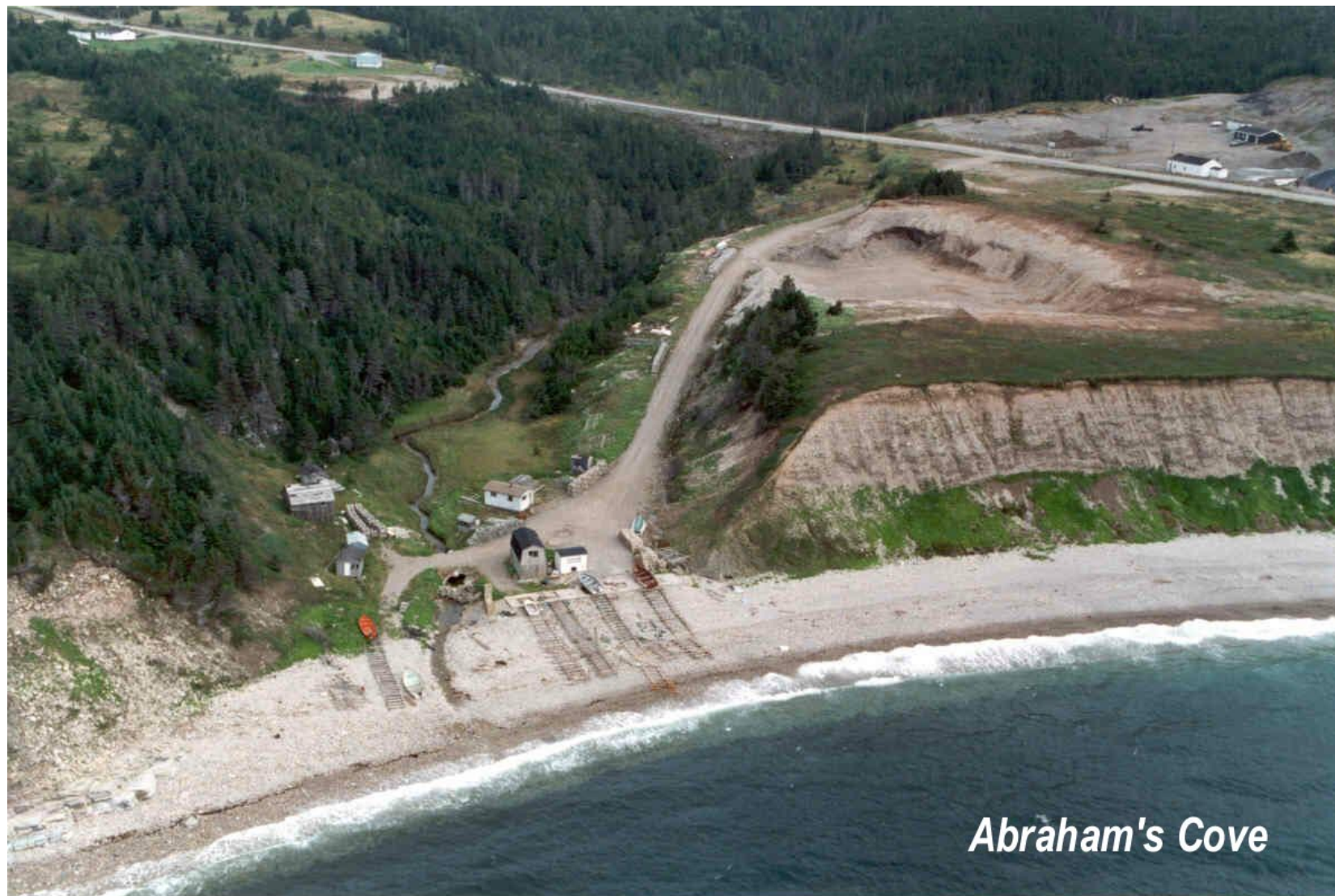
Photographie du site : vue aérienne du site de nivellement de la plage d'Abraham's Cove (voir rampes d'accès à l'eau).
