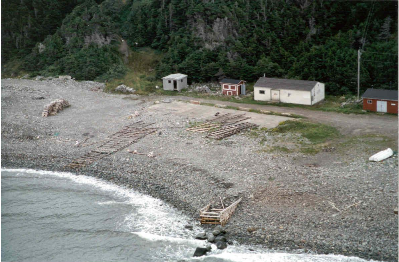
Photographie du site : vue aérienne du site de nivellement de la plage de Highlands.
