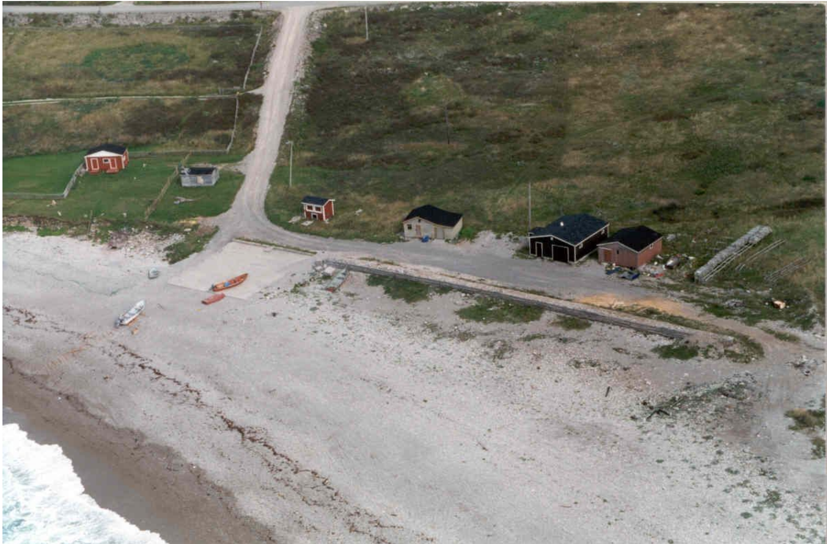
Photographie du site : vue aérienne du site de nivellement de la plage de Ship Cove.
