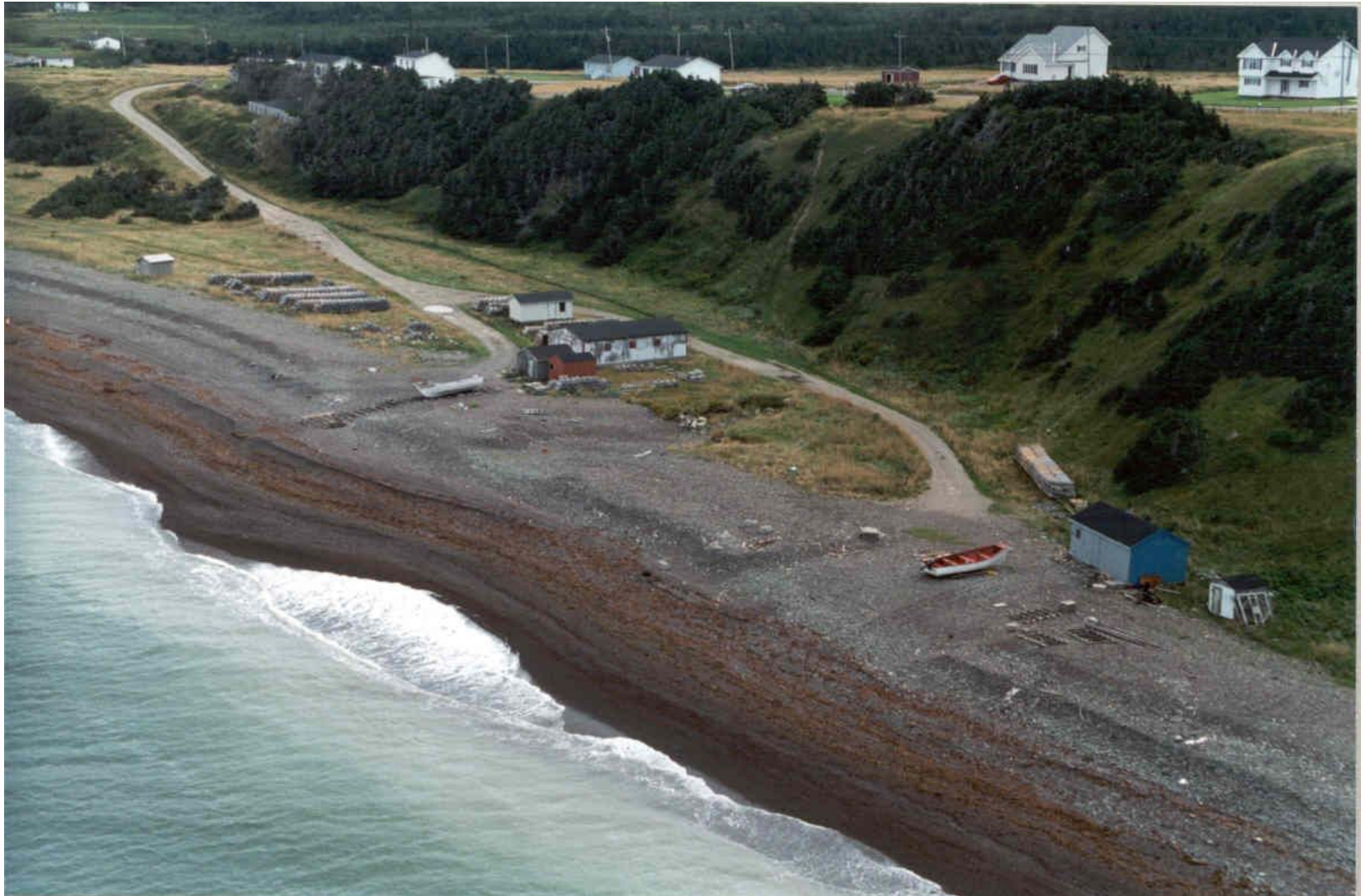
Photographie du site : vue aérienne du site de nivellement de la plage de Three Rock Cove – Collier’s Landing.
