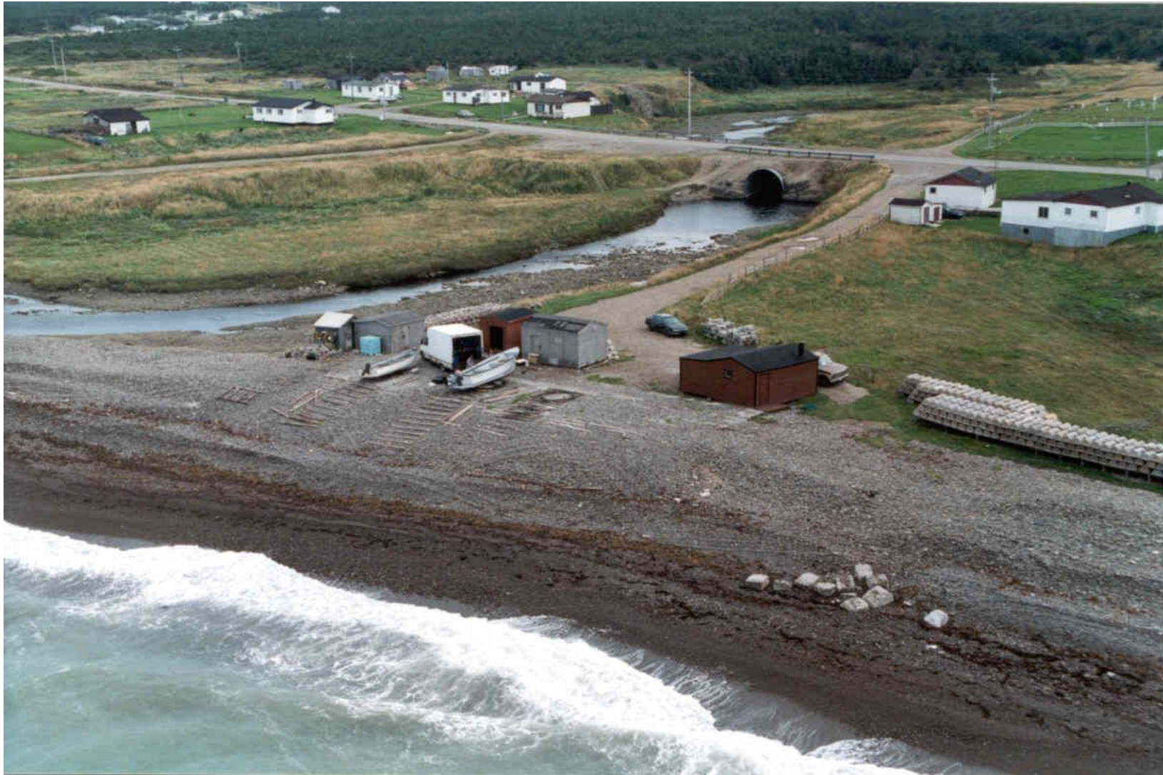
Photographie du site : vue aérienne de la plage de Mainland – du site de nivellement de la plage de Melvin Hink's .
