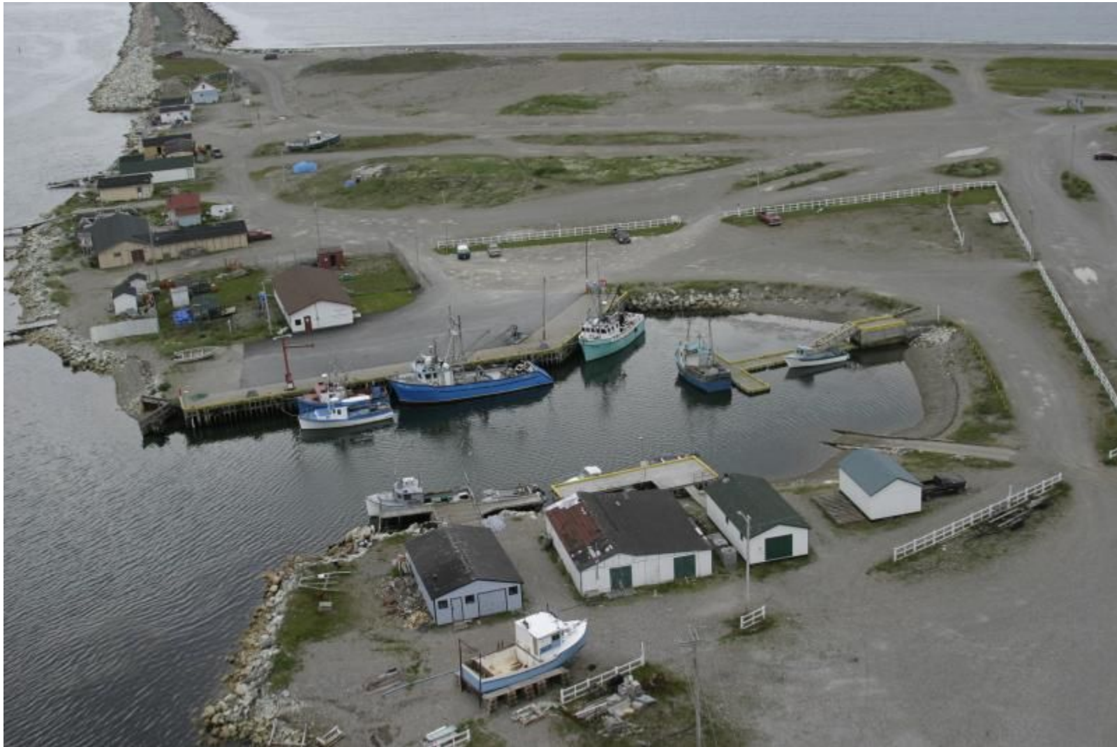
Photographie du site : vue aérienne du site de dragage de Little Port Harmon.
