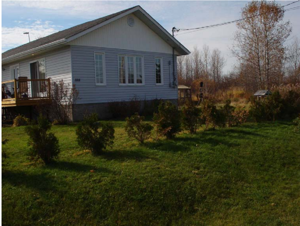
Photo 11 Disposition de la station de mesures au point P6
