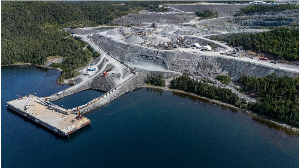
Figure 1.2 Installations existantes au terminal portuaire de Point Rousse
