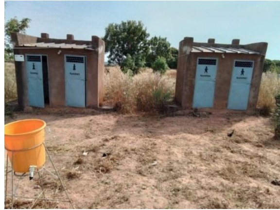
Photo 2 : CS Nafona : séparation des cabines hommes et femmes
