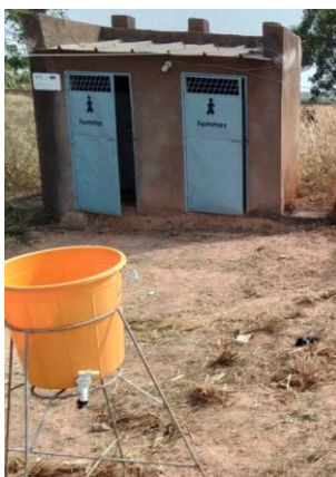
DLM Non fonctionnel devant un bloc de latrines CS Nafona
