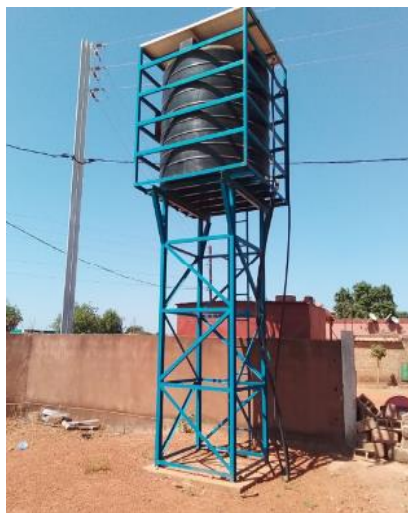
Réservoir d'eau CSPA Secteur 15
