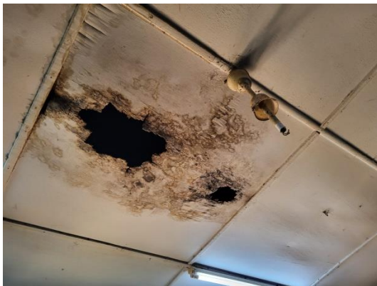
Planche 2: Salle de soins au CMA Sindou avec le toit qui coule à proximité de fil électrique Source PLURIELLES Mars 2024
