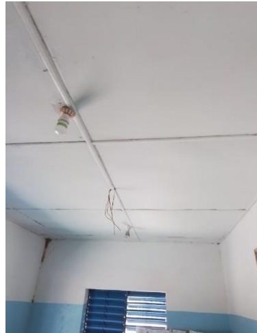
Mur et plafond en bon état CSPS Toumousséni
