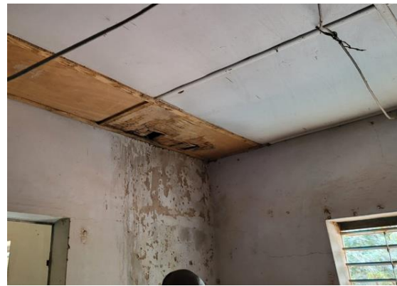
Planche 2: Salle de soins au CMA Sindou avec le toit qui coule à proximité de fil électrique Source PLURIELLES Mars 2024
