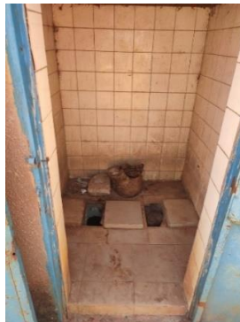
CS Secteur 8 Latrine bien entretenu
