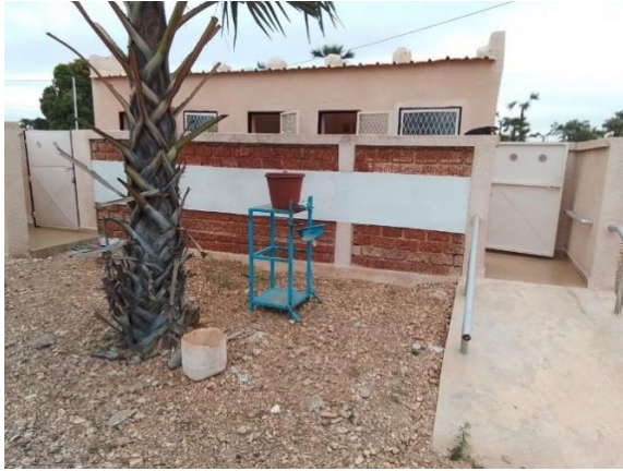
Photo 1 : CS Tiékouna : bloc de latrine accessible aux personnes à motricité réduite
