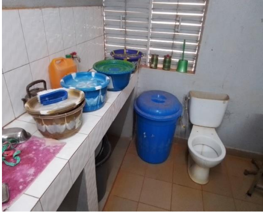
Photo 7 CSPS Secteur 15 Vidoir accompagné de fut servant de réservoir d'eau
