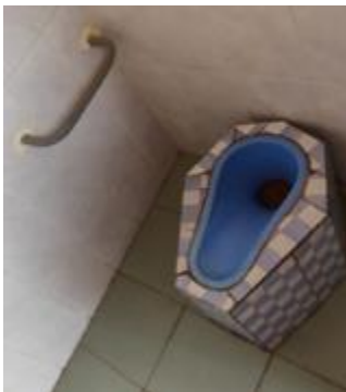
Grand-Popo réhabilitée PLURIELLES
