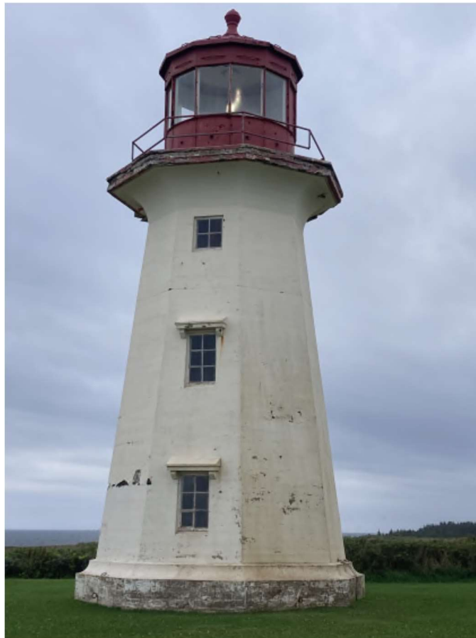
Photographie 2 : Phare - Peinture au plomb à retirer, repeinturage
