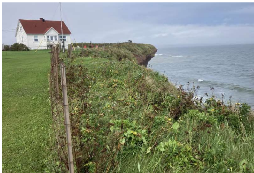
Photographie 7 : Clôture en bordure de falaise à remplacer
