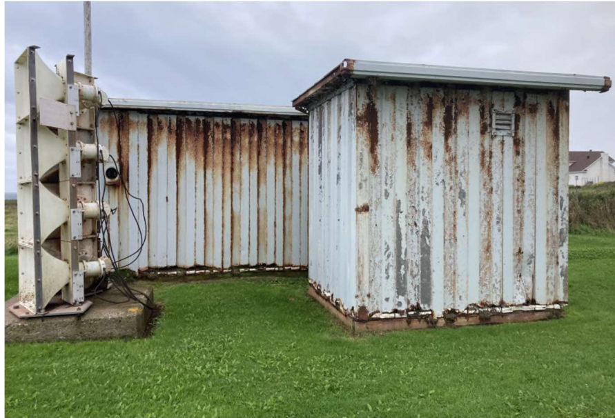
Photographie 6 : Remises à démanteler
