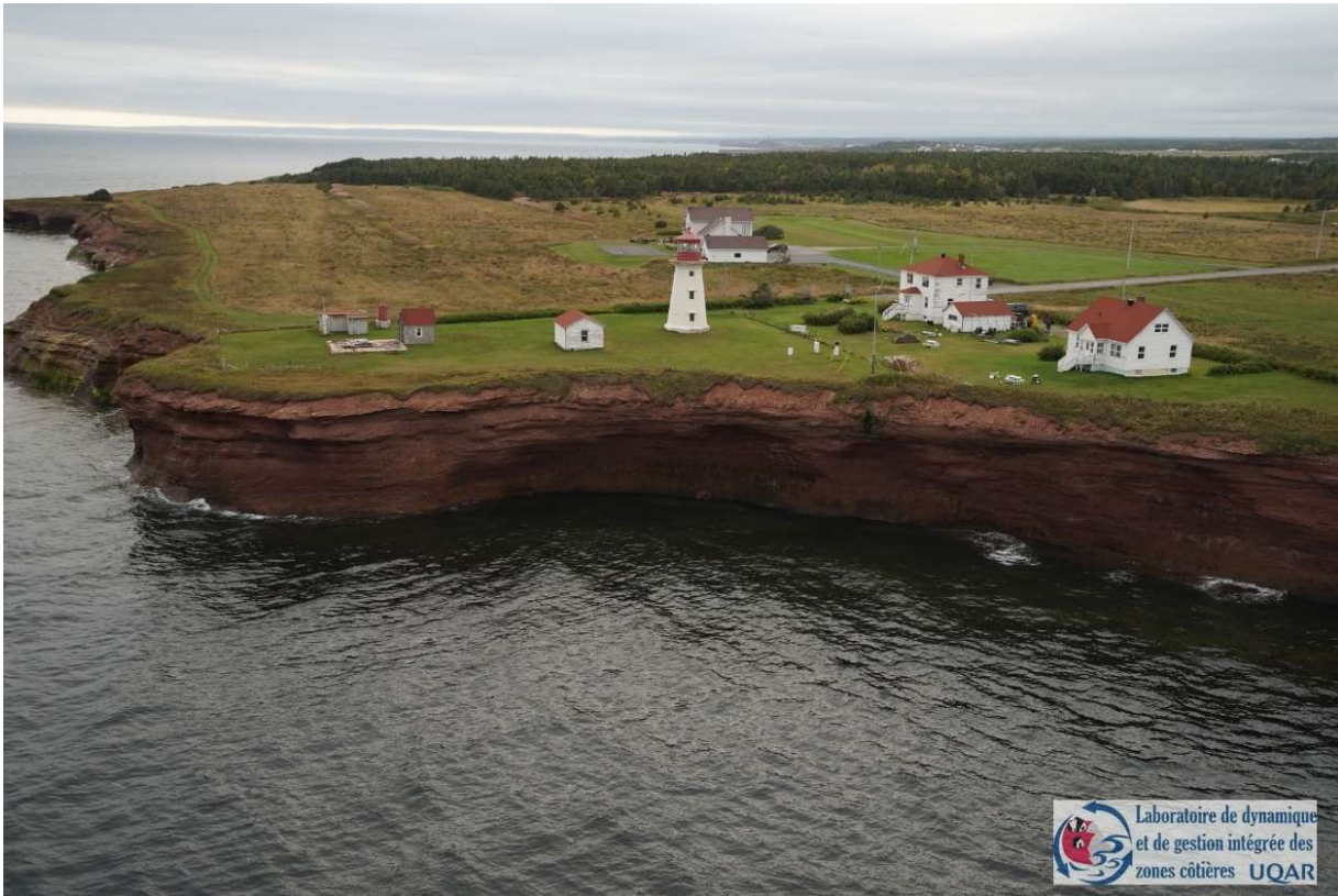
Photographie 3 Vue générale du site (Source UQAR, 2024)
