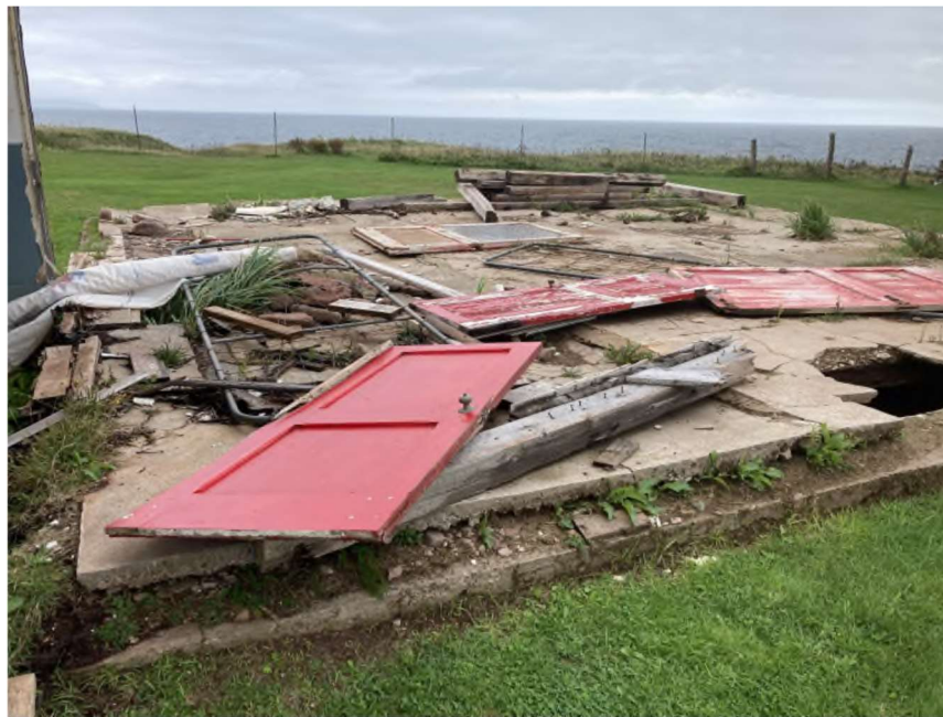
Photographie 5 : Dalle de plancher à démanteler
