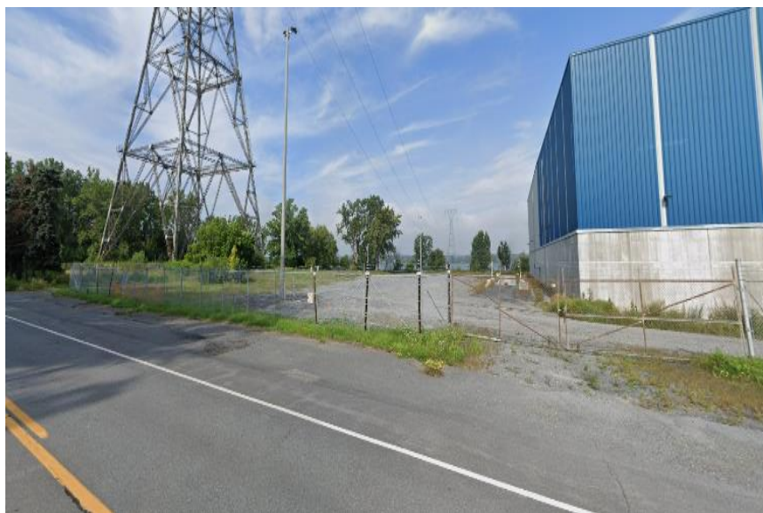
Photo 2 Coin ouest du site de l'entrepôt
