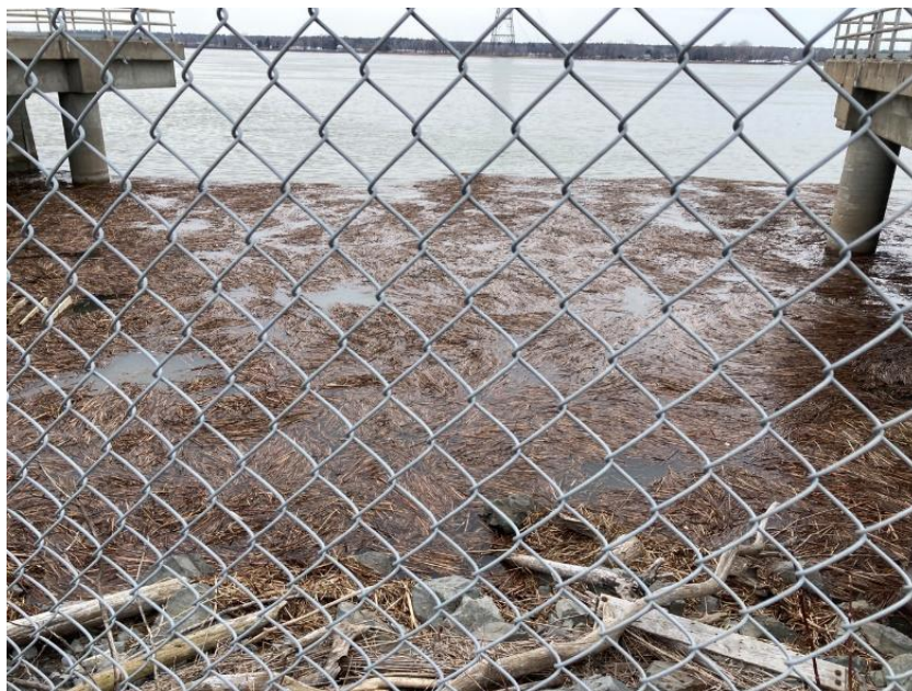
Photo 27 Présence de bois accumulé autour des quais
