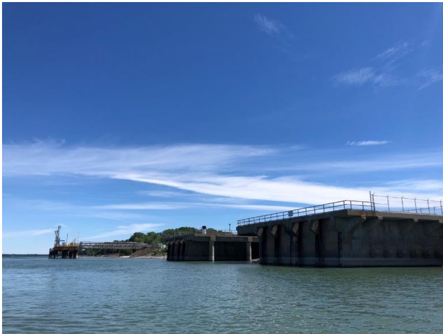
Photo 22 Zone du projet, vue général des quais
