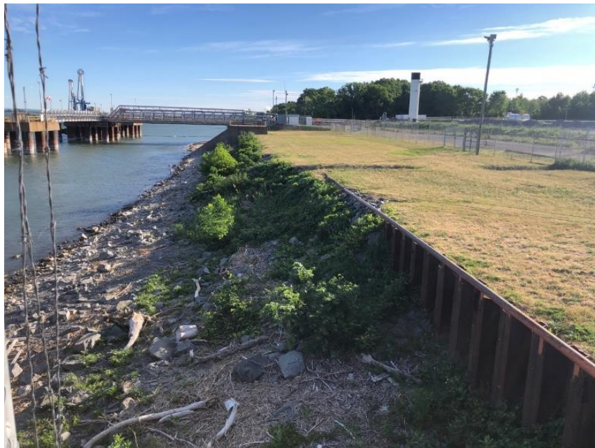
Photo 19 Zone du projet, coin est, vue vers Kildair Services Ltée
