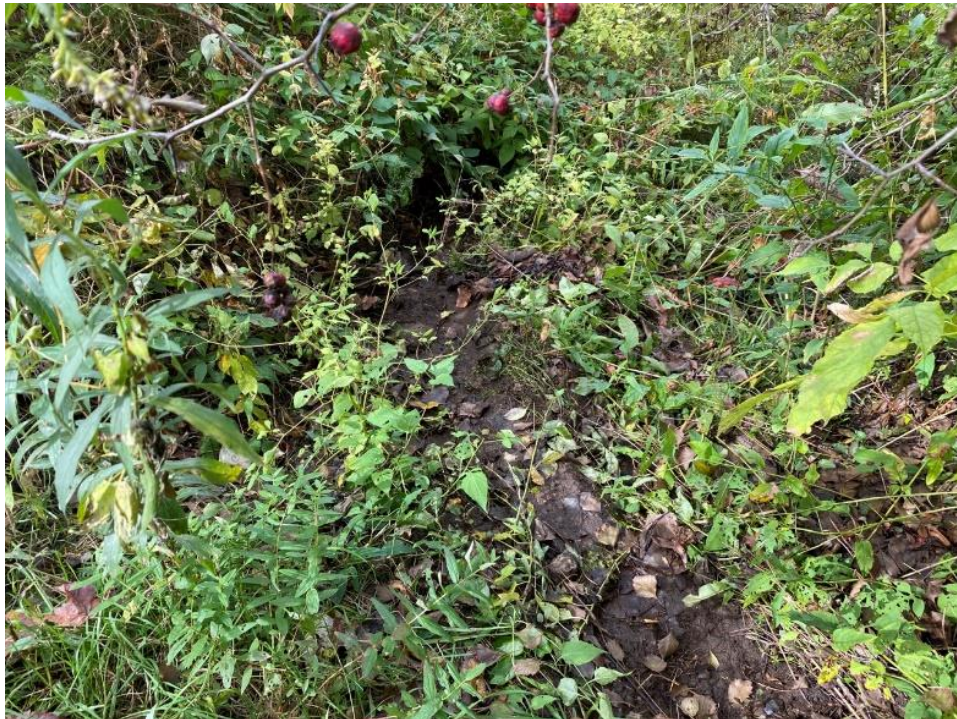
Photo 6 Franchissable avec réserve à la jonction avec le fossé de route de la 132
