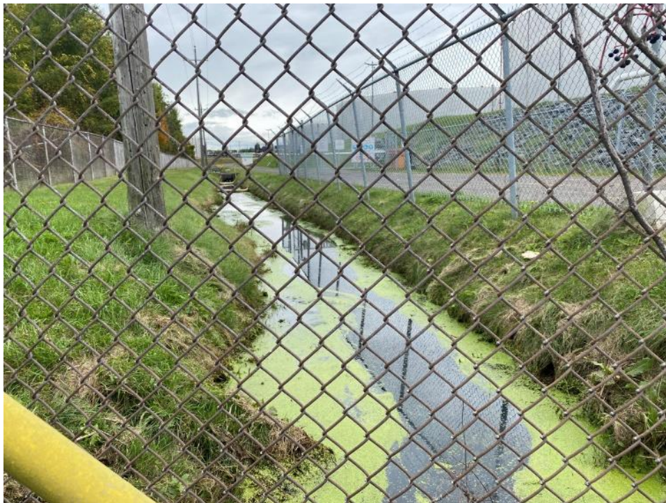
Photo 26 Fossé côté nord de Kildair services
