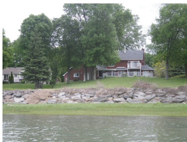
Photo 2 : Berges enrochées avec une pente plus douce
