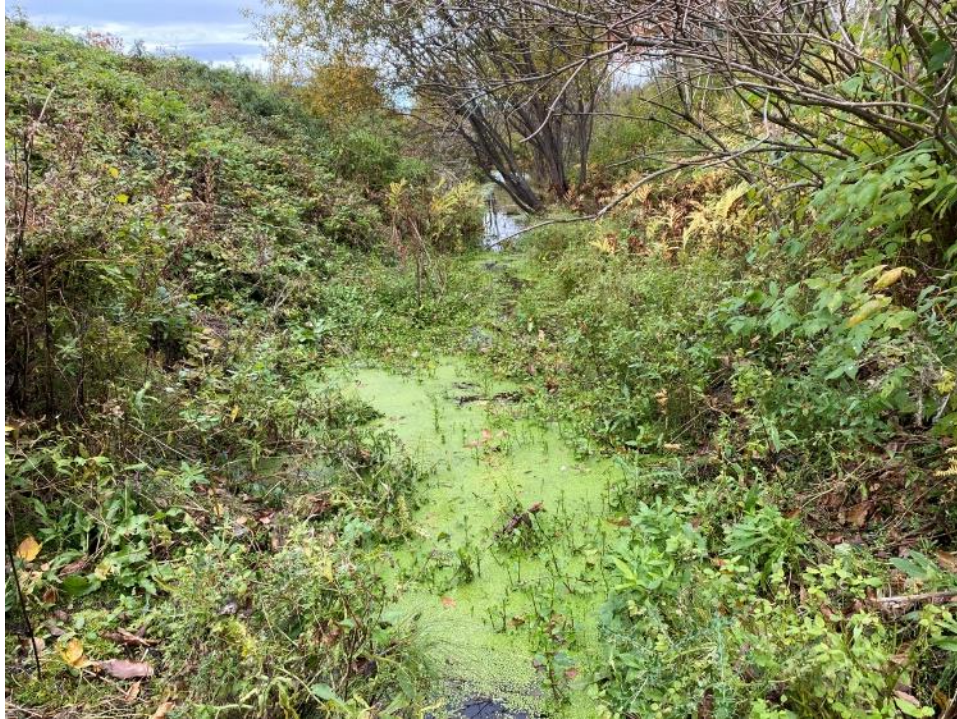
Photo 23 Section centrale du fossé en lisière de l'ancien poste
