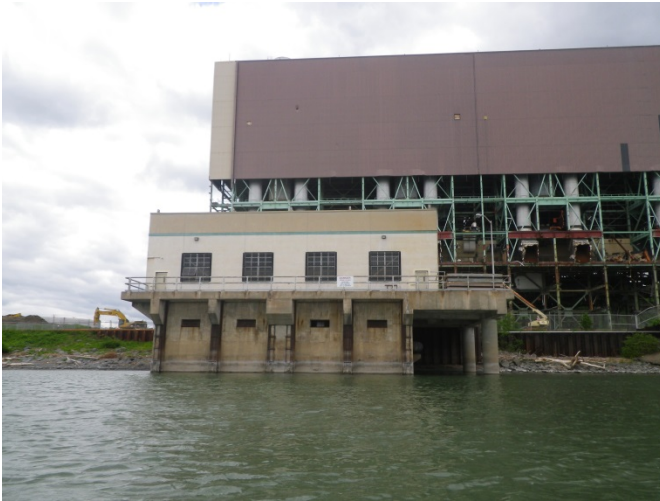
Photo 5 : Station de pompage
