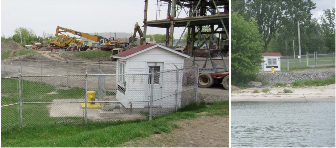
Photo 8 : Bollards amont (gauche) et aval (droite) de la compagnie Kildair
