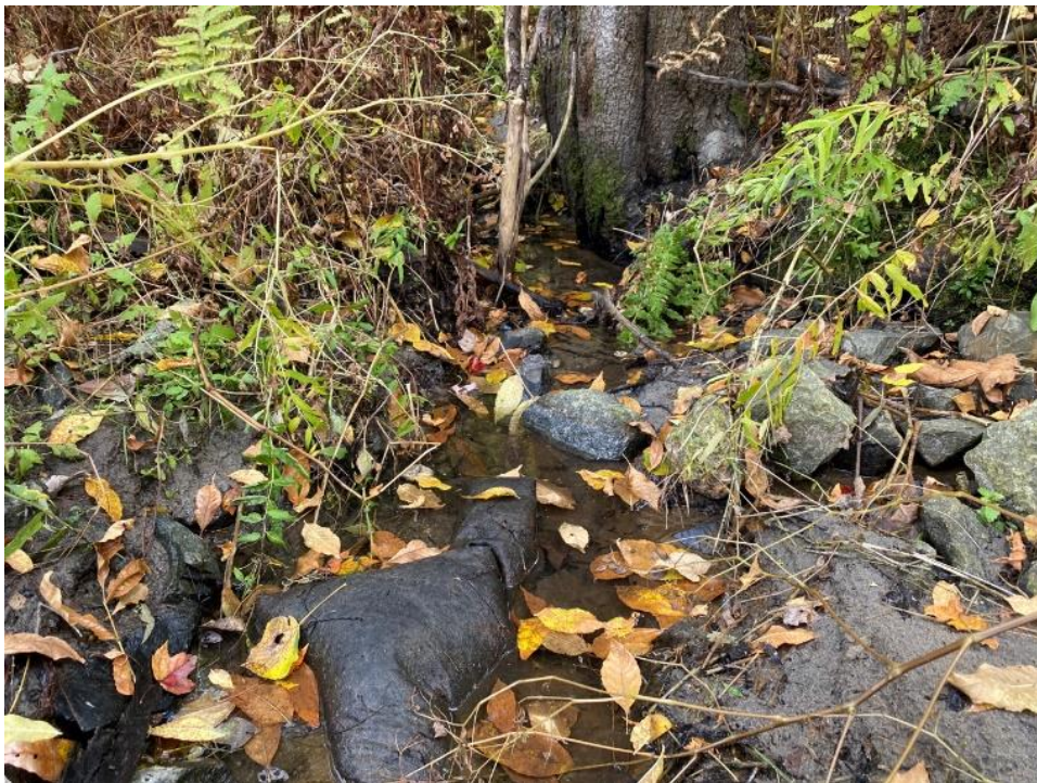
Photo 28 Aval du fossé drainant MT11
