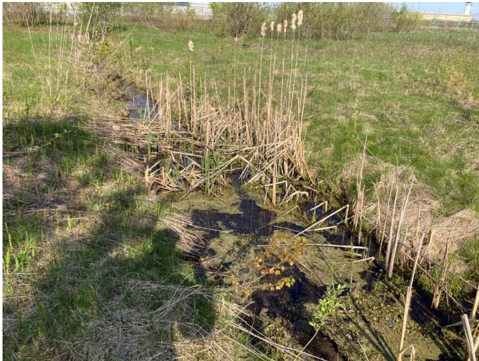
Photo 18 Jct des fossés centraux redirigé vers l'ancien poste électrique
