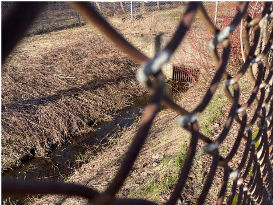
Photo 14 Section aval, avant de traverser la route
