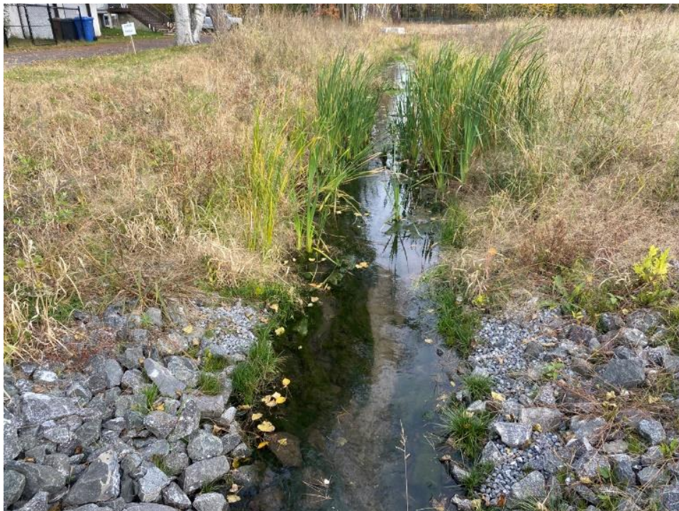
Photo 30 Fossé de la rue Paul-Pauzé canalisé vers étang artificiel
