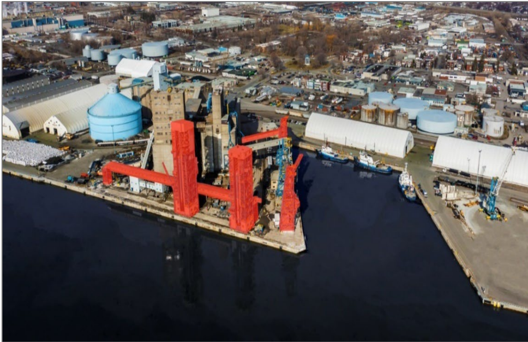
Photo 3-3 : État actuel des lieux
