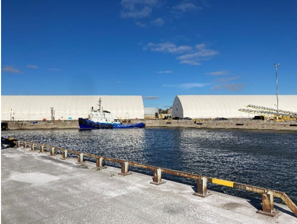
Photo 3-1 : Vue actuelle du bassin formé par les quais 14, 15 et 16.
