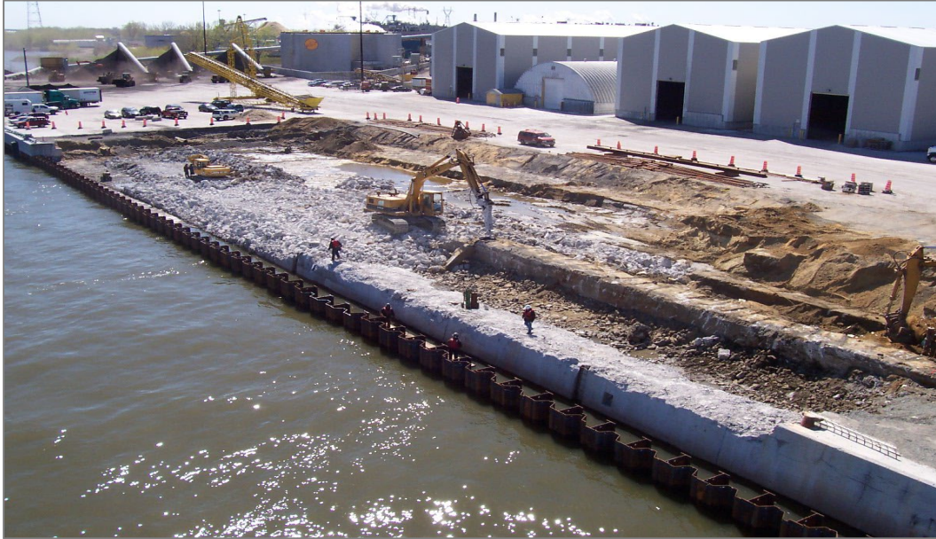
Photo 3-5 : Reconstruction progressive (de l'ouest vers l'est) d'un mur de palplanches avec tirants horizontaux et mur d'ancrage au quai 19 en 2005
