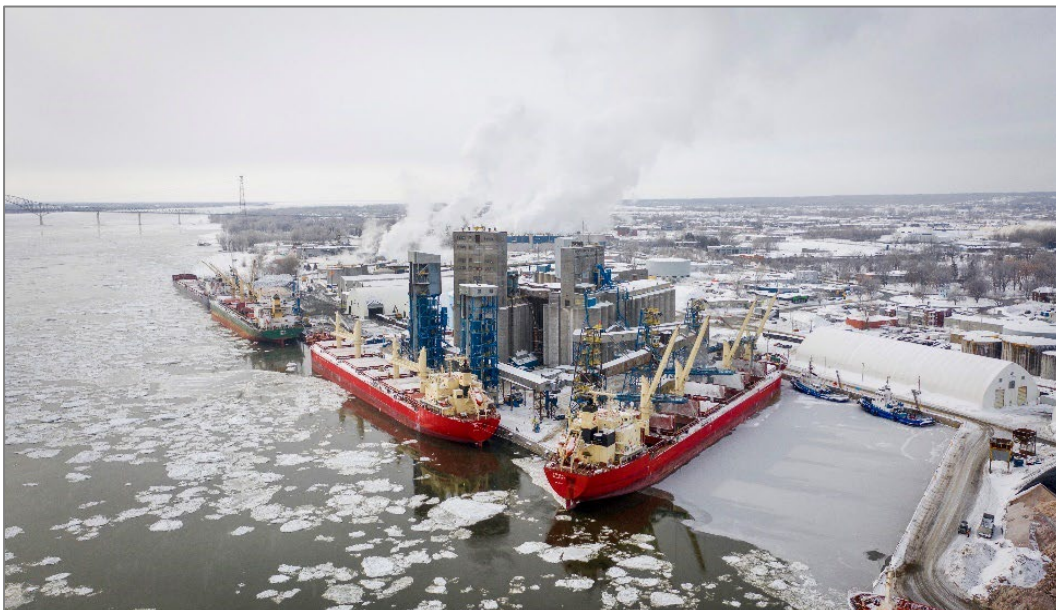
Photo 1-1 : Photo actuelle des quais 16 et 17
