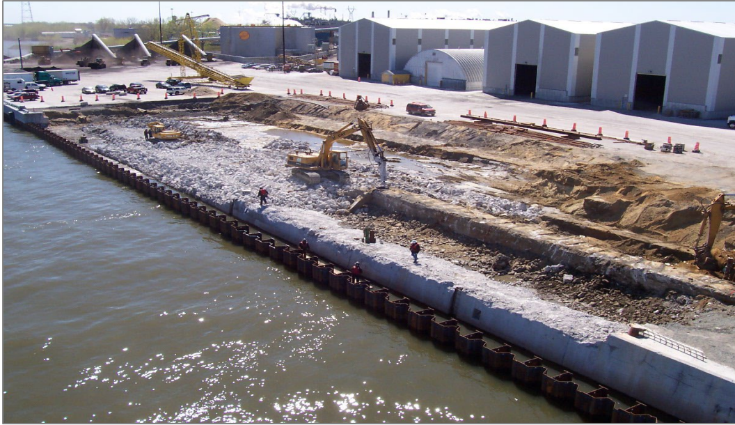
Photo 3-4 : Reconstruction progressive (de l'ouest vers l'est) d'un mur de palplanches avec tirants horizontaux et mur d'ancrage au quai 19 en 2005
