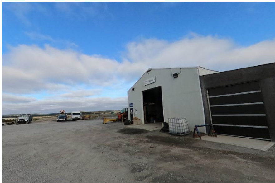
Photo 23.12 Entrepôts pour les lieux de travail, Stantec, octobre 2023
