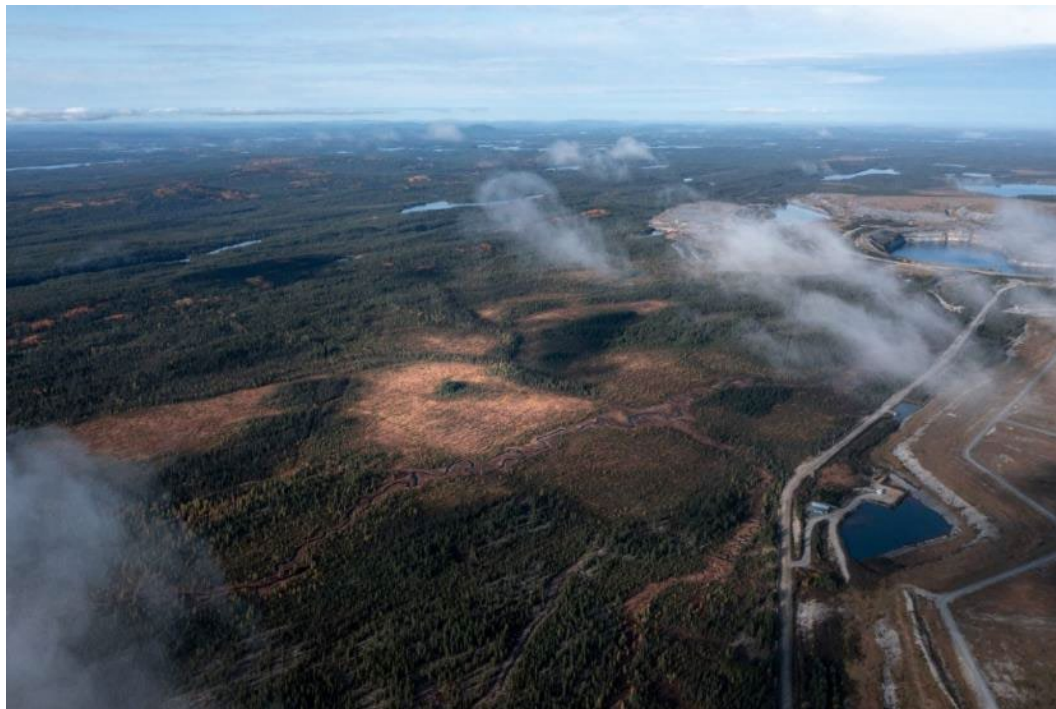
Photo 23.1 Site de la mine Troilus, Stantec, octobre, 2 023
