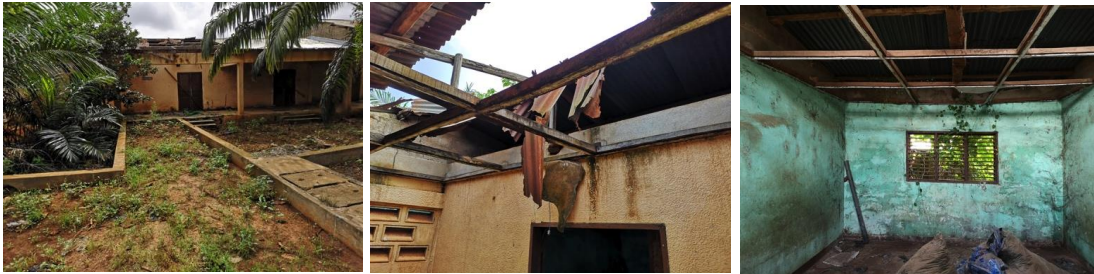
Bâtiment affecté au CAAD au CS de Pahou
