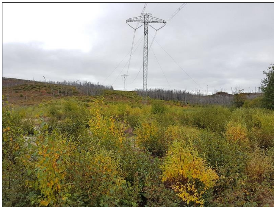
Photo 6-13 Unité de paysage de ligne de transport d'énergie, vue depuis la vallée de la rivière Eastmain vers les équipements de transport d'énergie
