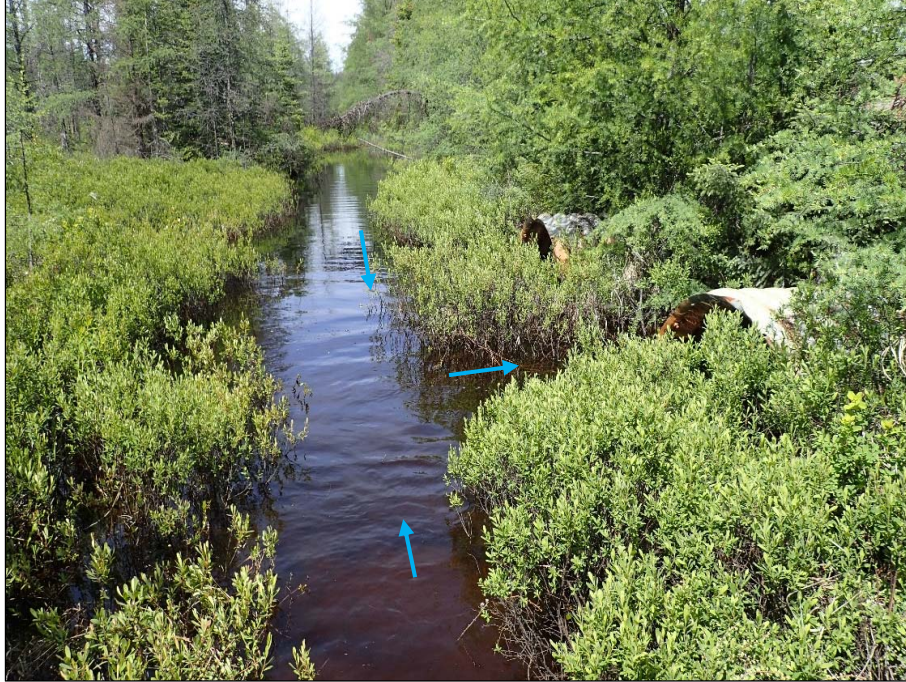
Photo A-23 : Cours d'eau CE4 – Juin 2017, amont du double ponceau traversant la route de la Baie-James, vue vers l'amont
