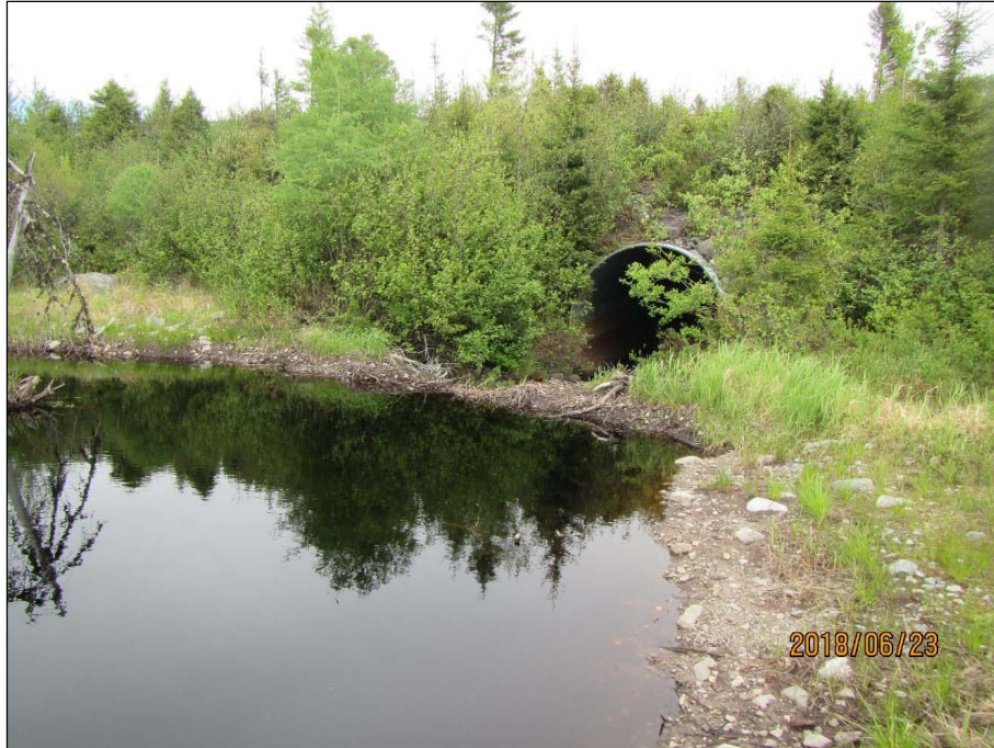
Photo A-19 : Cours d'eau CE3 – Juin 2018, barrage de castor en amont du ponceau sous la route de la Baie-James
