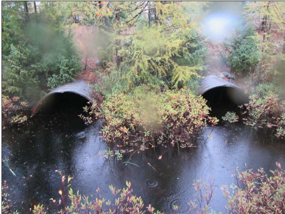
Photo A-24 : Cours d'eau CE4 – Octobre 2017, amont du double ponceau traversant la route de la Baie-James
