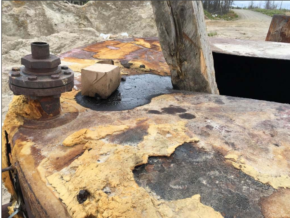
Photo E-3 : Dessus d'un des conteneurs – Présence d'une tache huileuse
