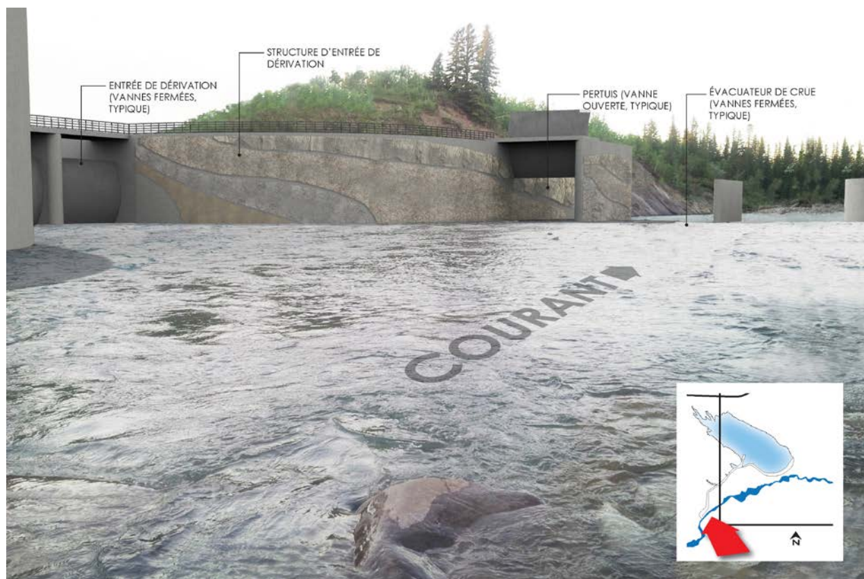
Figure 6 Ouvrage de dérivation
