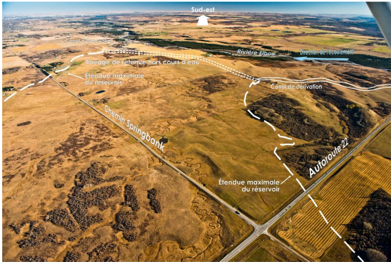
Figure 5 Vue vers le sud-est du réservoir de retenue, du barrage de retenue hors cours d'eau et du canal de dérivation
