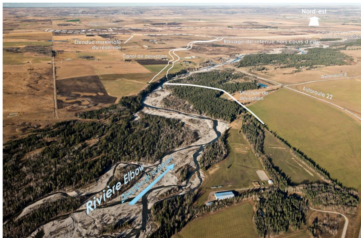
Figure 4 Vue vers le nord-est de l'ouvrage de dérivation, du canal de dérivation, du réservoir de retenue et du barrage de retenue hors cours d'eau
