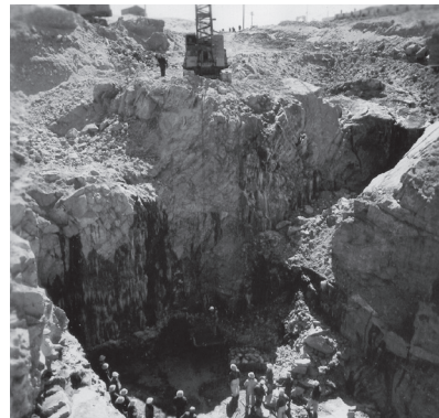
Roche excavée lors de la construction du réacteur RND
