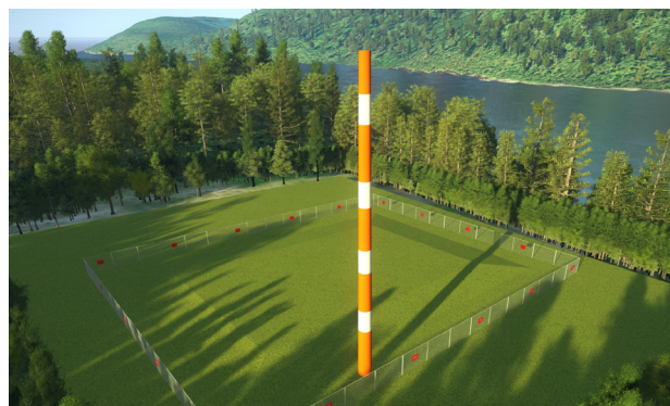
Représentation de l'IGDRND une fois le déclassement complété. La cheminée de ventilation est conservée comme habitat pour les martinets ramoneurs
