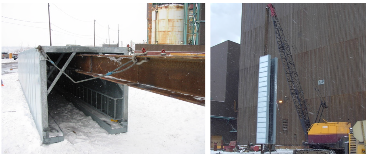
Figure 2 Enceinte acoustique pour battage de pieux
