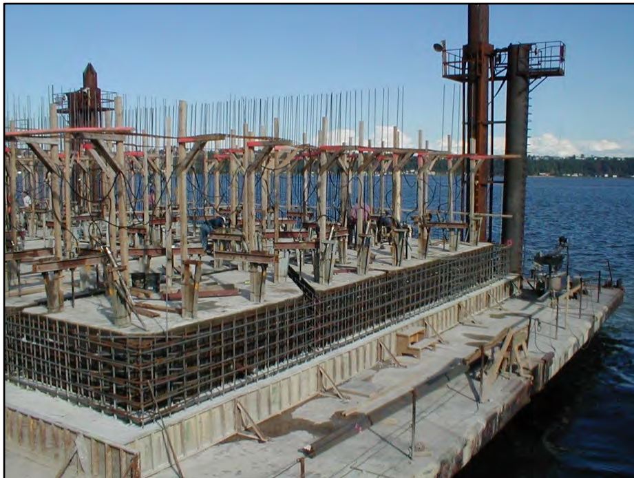
Figure 7 Fabrication d'un caisson sur une barge submersible
