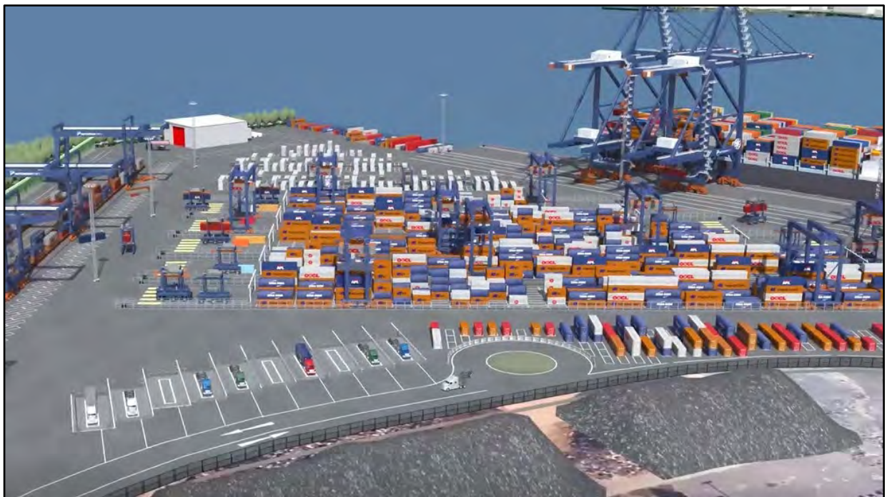
Figure 12 Vue générale de l'espace principal en arrière-quai
