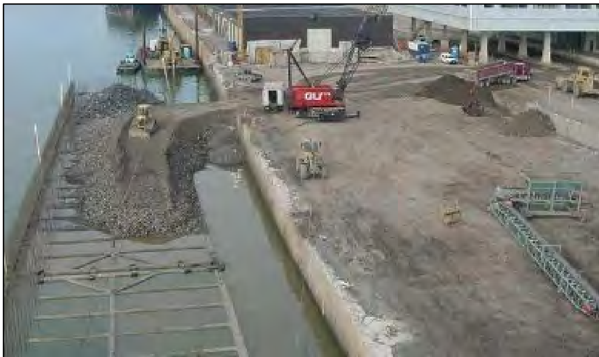
Figure 9 Remplissage des caissons
