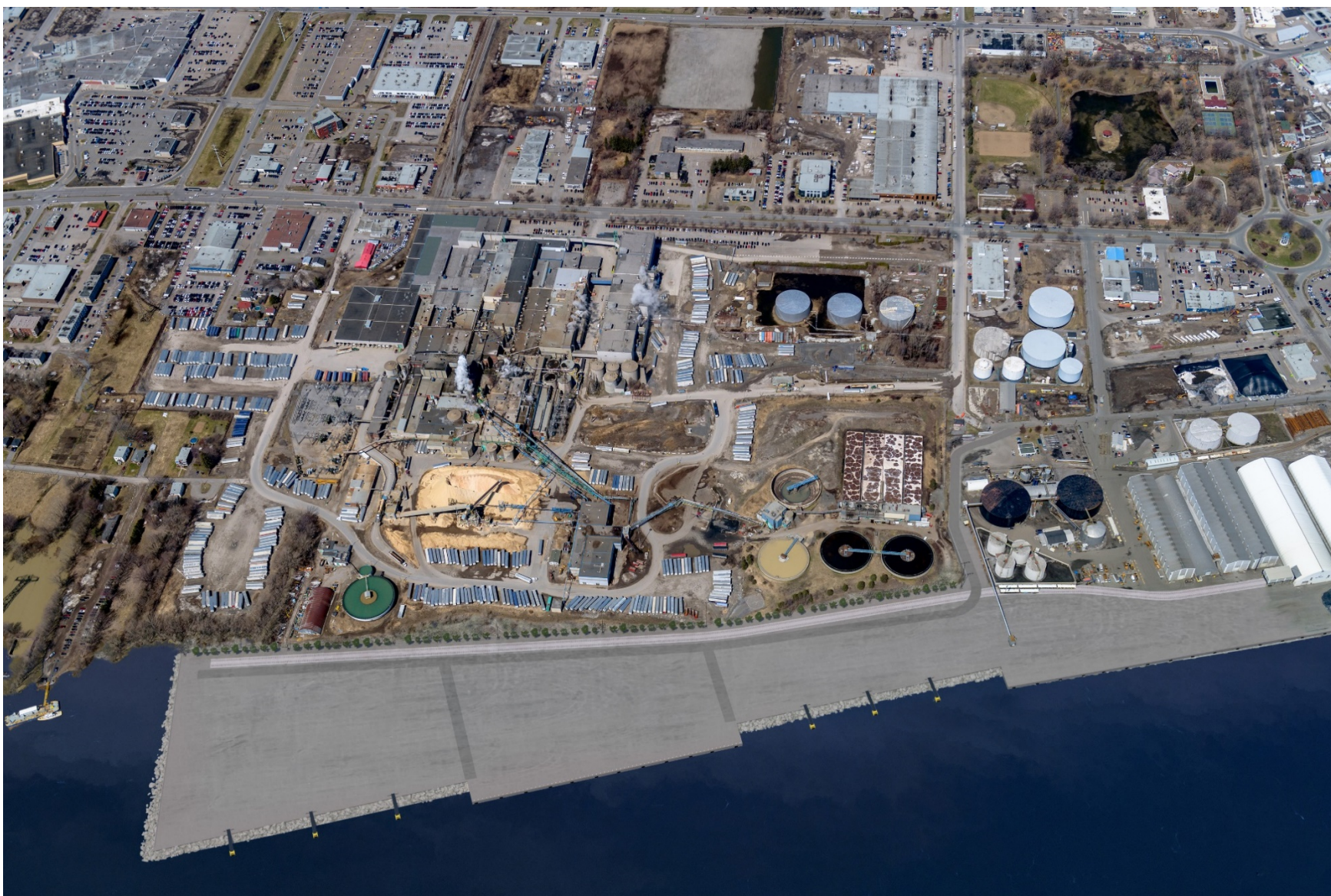
Figure 3 : Terminal 21 (quais 21, 22 et 23)
