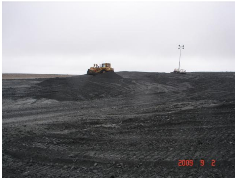
Photo 2-2 Déposition de résidus filtrés à la mine Raglan, Xstrata Nickel
