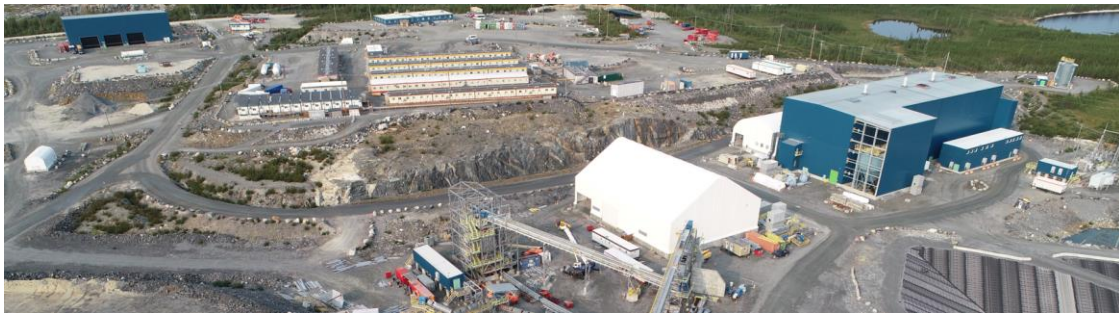
Figure 9. Boucle de chemin allant au concentrateur (portion ouest) – Site Whabouchi, septembre 2024
