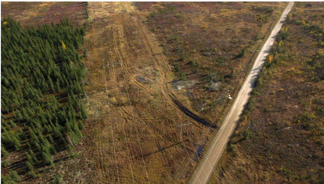
Figure ES. 4.9 Vue aérienne du site proposé pour l'usine de traitement du minerai
