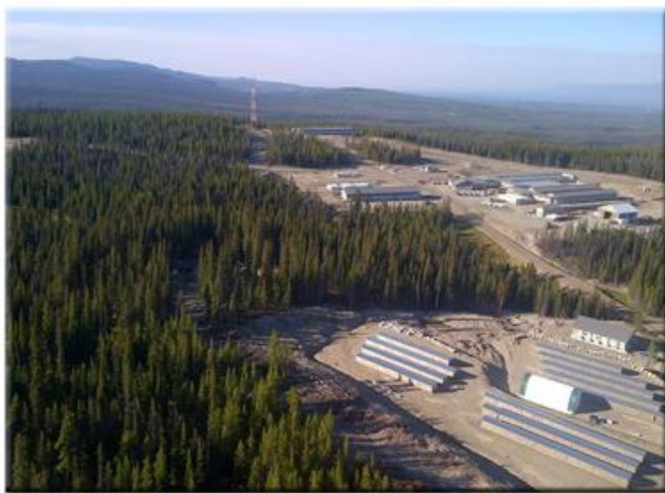
Photo ES 1 : Vue aérienne du camp d'exploration de Blackwater
