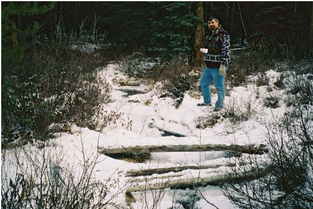
Photo 15. Ruisseau se jetant (poteaux 447-446), decembre 2002 . Il semble que le ruisseau coule toute l'année. Comme les berges sont peu élevées et stables, on peut traverser le ruisseau sur des troncs d'arbres, donc on dispose d'un accès permanent
