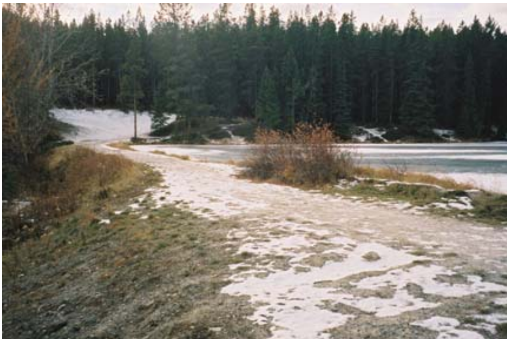
Photo 2. Berme à l'extrémité est du lac Johnson, novembre 2002. Le lit du ruisseau est de la berme est sec (poteaux 249-248, 253-252 et 259-258).
